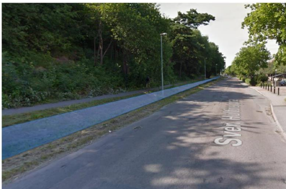
Figur 15: Illustration av diket som behöver breddas för att höja kapaciteten.
