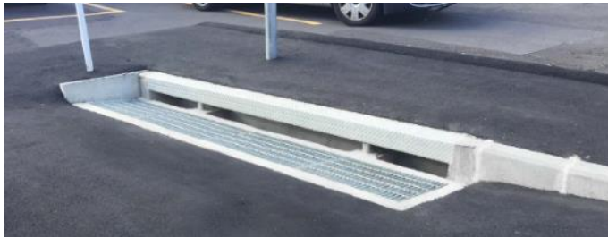
Figur 18: Exempel på rännstensbrunn med hög kapacitet (500–800 l/s) (bild från Hynds - Megapit).
